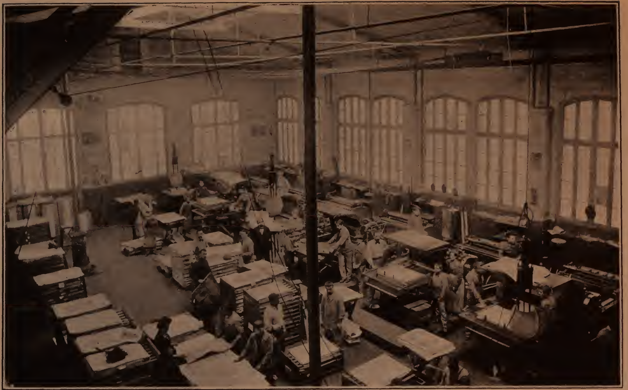
Vue générale d'un atelier de machines lithographiques (entièrement conduit par l'électricité).
